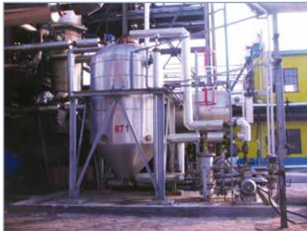
Рис. 7. Блок кавитационного термолиза на НПЗ-Ясло (Польша)
